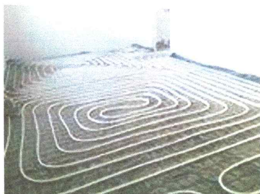
Instalație de încălzire în pardoseală montată pe armătură
