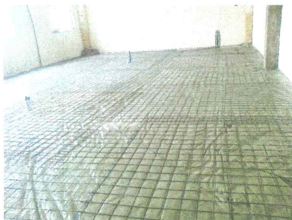
Pat granular acoperit cu folie și armătură din plasă sudată pregătit pentru turnarea sapei
